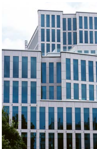
I december invigdes LINK Business Center i Linköping, byggt av Lundbergs Fastigheter.
